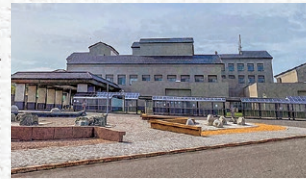
Hokkaido Esashi Hospital
