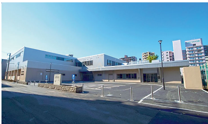
新リハビリテーション実習棟 （平成26年9月完成）
